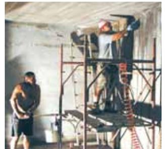
*La dotazione indispensabile per realizzare interventi di impermeabilizzazione attiva, mediante iniezione di resine poliuretatiche SYNTECH H.A.G. è ovviamente rappresentata dalla resina stessa, completa di attivatore, da una pompa adeguata, manuale, pneumatica od elettrica, dagli specifici iniettori a vite, nonché da un agente di pulizia idoneo. Per il più agevole svolgimento delle operazioni è comunque consigliabile predisporre anche gli "accessori complementari" riportati a pagina 8 e 9.*
